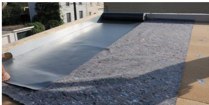
Mise en place d'étanchéité sur isolation polyuréthane
